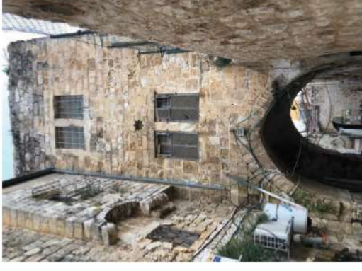
لوحة (١٣٦) قنطرة في عتبة دروش بمقد مزدوج الصبح ونجمة شمالية ومقد طابج
