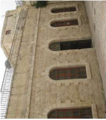
لوحة (١٤٦) بروز عضادات الشبلييك عن سمت الواجهة في مبنى العملية بالمعمارة العمارة
