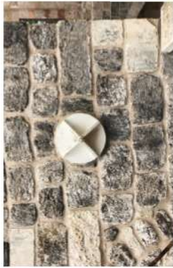
لوحة (٣٦) رابط حديدي بنقوي بشكل اسطواني في القسم العلوي من المدرسة الجوهريه
