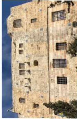
لوحة (٣٥) روابط حديدية في الواجهة الجنوبية للمدرسة الجاهلية
