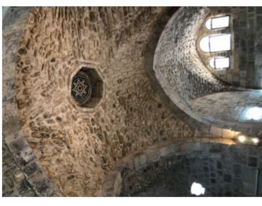
لوحة (٢٠٨) قبو مروحي وقبو مقاطع مبنى الدقشوم في صحن المدرسة الطشتمرية
