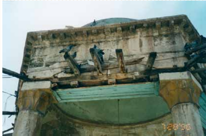
الجامع الأموي - حلب: تدهور الأحجار والأخشاب: عدم الصيانة
