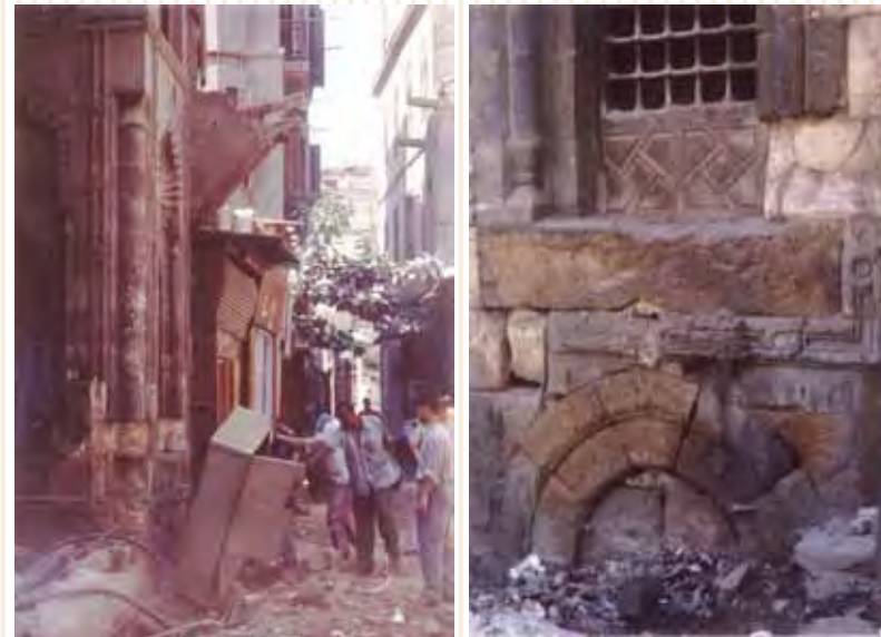
حوض شرب الدواب نقل صندوق الكهرباء الملاصق للمبنى
