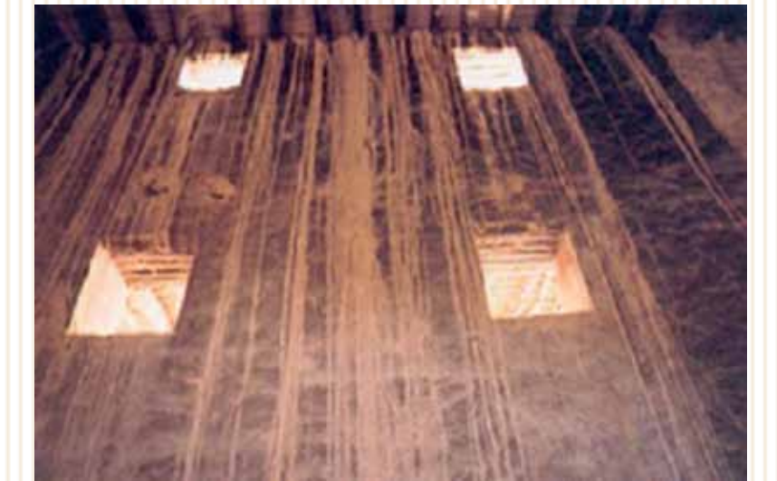
مجارى حفرها النمل الأبيض للوصول للمادة العضوية بالسقف
