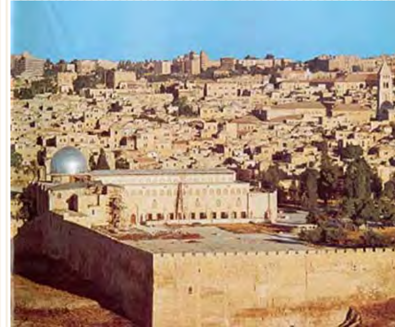
المسجد الأقصى والركن الجنوبي الشرقي من الحرم الشريف
