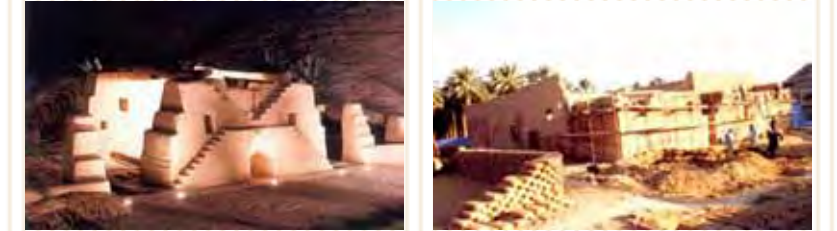
المنزل الريفي – الواجهة الغربية أثناء العمل
