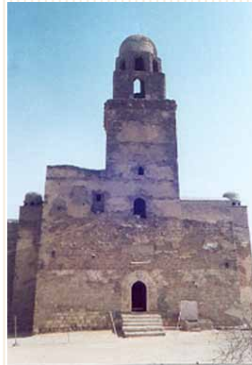
مسجد الجيوشي - إعادة إنشاء تحت مسمى الترميم
