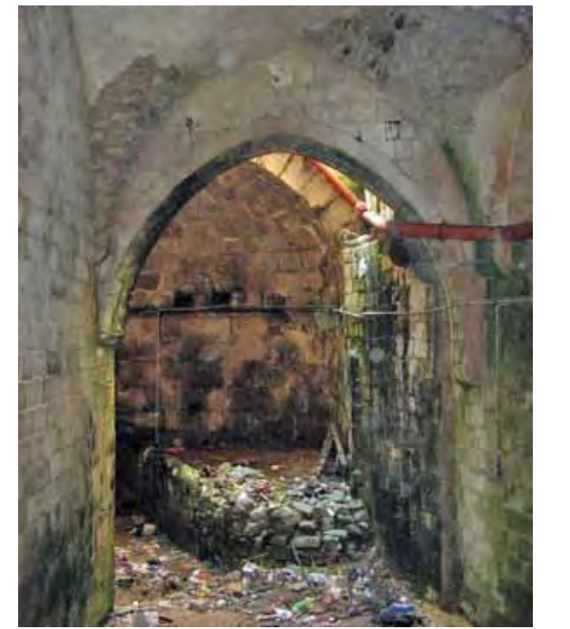
صورة (2.9): الخطوط المكشوفة لشبكة الصرف الصحي
