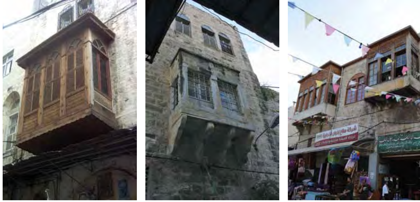
صورة رقم (23.5): بعض مشربيات البلدة القديمة ويظهر استعمال الحجر أو الخشب في البناء
